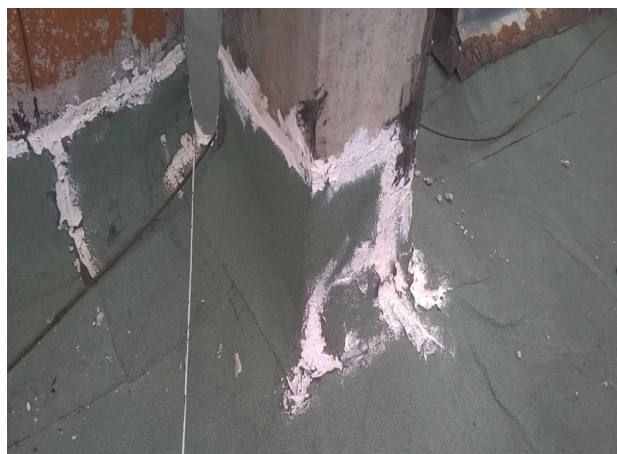
Фиг.1.19-Състояние на плосък покрив, хидроизолация около комините.
