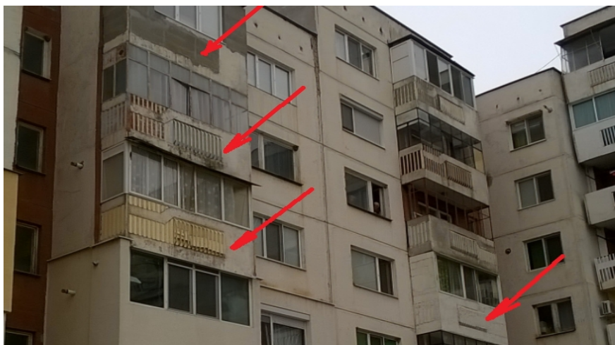
Фиг. 1.10.-Състояние на иззидана стена на приобщени и остъклени тераси, при парапети
