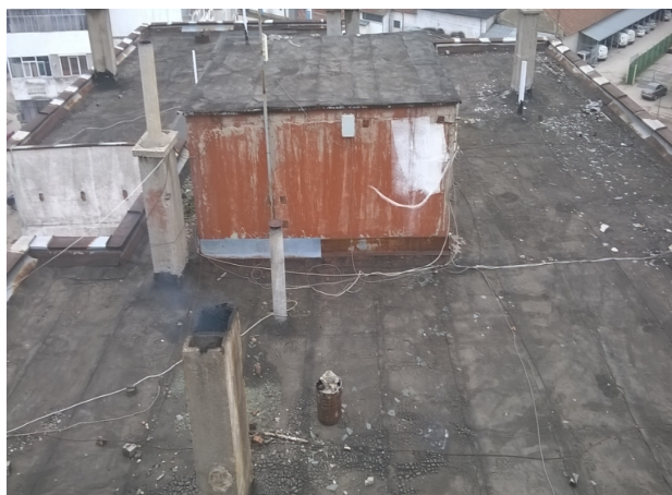
Фиг.1.19-Състояние на плосък покрив, хидроизолация около комините.
