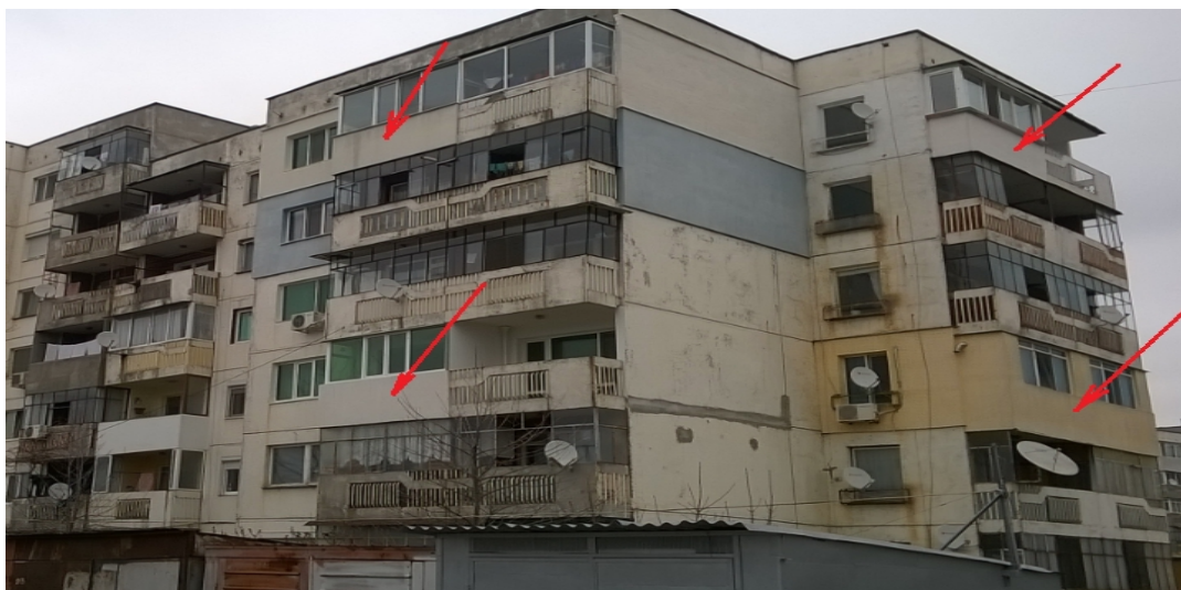
Фиг. 1.12.-Състояние на иззидана стена на приобщени и остъклени тераси с изолация, при парапет
