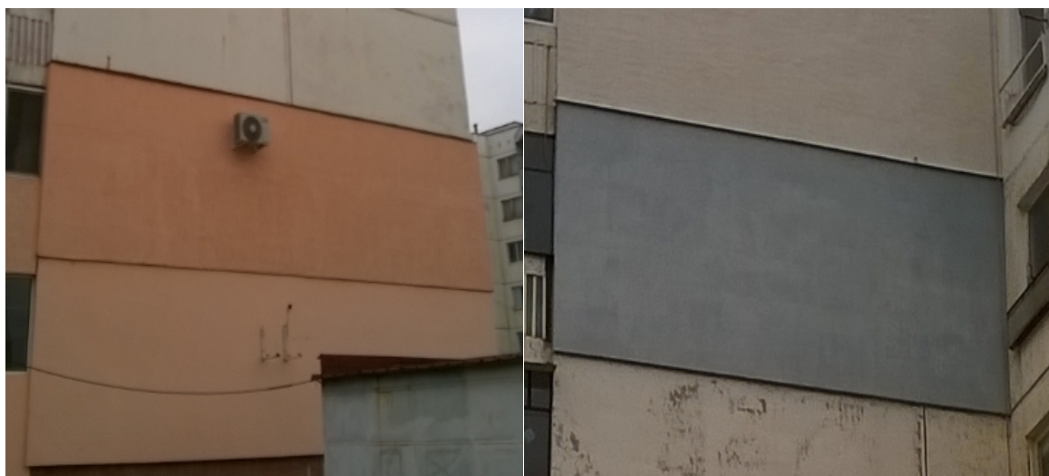
Фиг.1.8-Състояние на външни топлоизолирани стени
